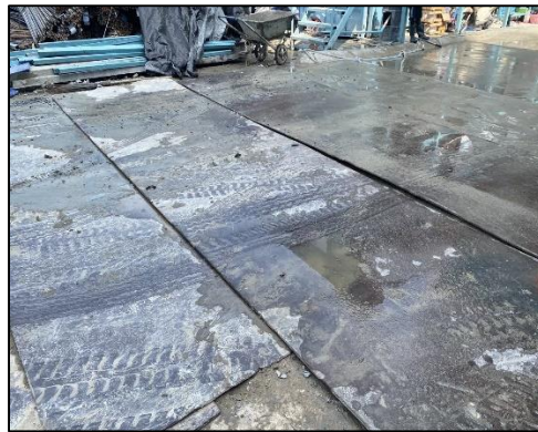
ภาพที่ 18 แผ่นเหล็กปูบริเวณภายในพื้นที่โครงการ
